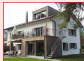
Anbau und Schleppdach
